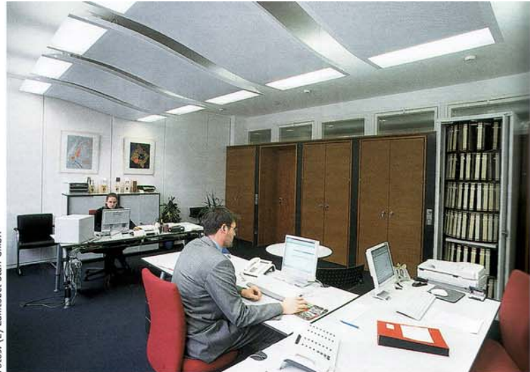
Die dynamisch geschwungenen Deckensegel der Büroräume vereinen Licht, Schallschutz, Heizung und Kühlung in sich.
